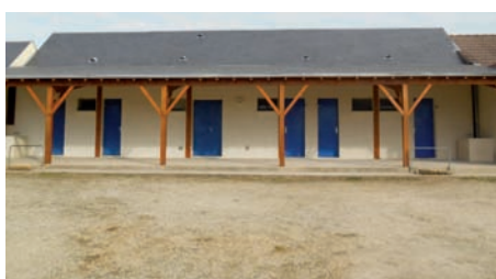
Mise en place de portes neuves métalliques au Stade Baquet par l'entreprise ALVES.
