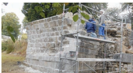
Réfection et mise en valeur de la tête de l'ancien Pont (« romain ») par l'entreprise PERADON.
