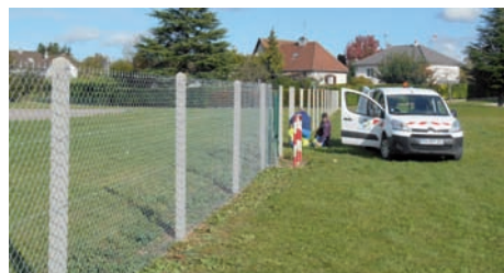
Rénovation de la clôture du Stade M. Baquet par les Services Techniques Municipaux.
