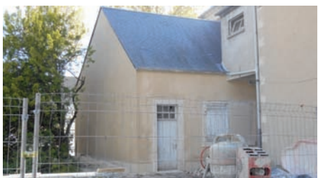
Ravalement du Local Municipal 73 av. Gabriel Dordain par l'entreprise PERADON.
