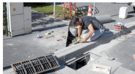
Pose d'une grille avaloir sur trottoir rue Marcel Lafleur par les Services Techniques Municipaux.
