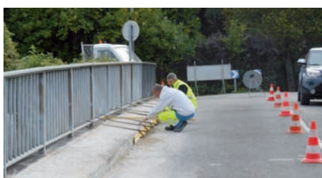
Réfection des trottoirs du pont du breuil par les Services Techniques Municipaux.
