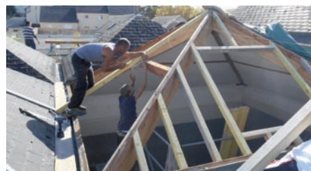
Rénovation et l'isolation de 2 pyramides en toiture de la médiathèque. Travaux réalisés par l'entreprise DOUET.
