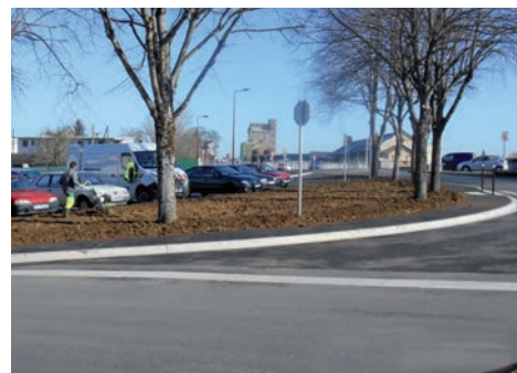
Aménagement paysagé du parking de la Gare
