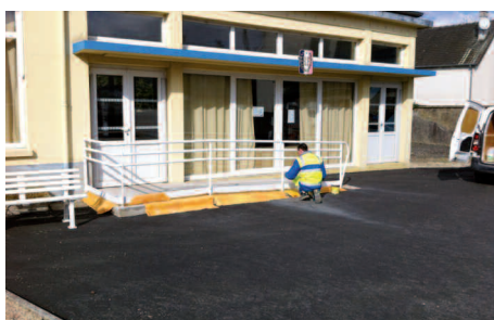
Installation d'une main courante sur la rampe d'accès aux handicapés à la maternelle Rive-Gauche
