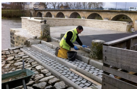
Emmarchement et empierrement sur l'ancien pont romain – Quai du Cher réalisation services techniques municipaux
