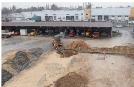
Travaux de raccordement en eau pluviale de la cuve enterrée se situant aux services techniques. Cette récupération d'eau permettra d'arroser dès cette année le fleurissement en jardinières à moindre coût.
