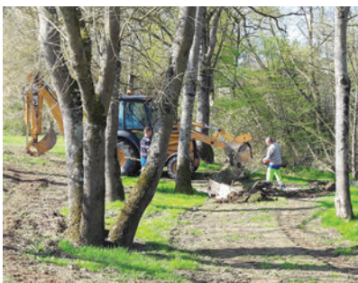
Nettoyage par les STM des arbres morts sur la fausse rivière.
