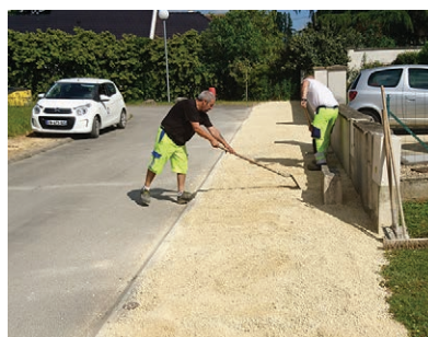
Réfection des trottoirs en grave calcaire du quartier du Nivernais
