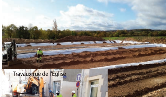
Travaux de terrassement de la nouvelle station d'épuration
