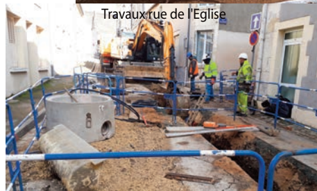
Travaux rue de l'Eglise
